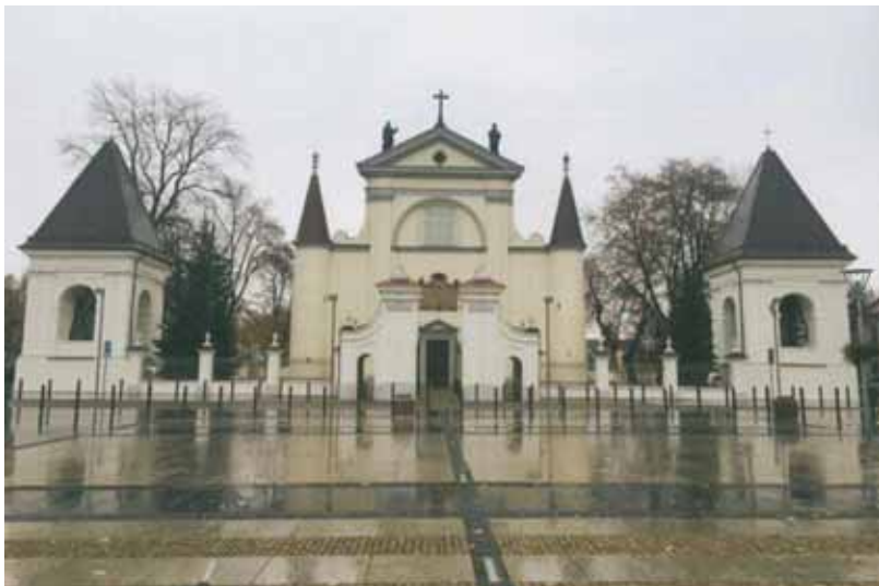
▲ Wykonanie izolacji poziomej i remontu muru wokół kościoła wraz z bramami i dzwonicami na terenie zespołu sakralnego kościoła pw. Wniebowzięcia Najświętszej Marii Panny w Węgrowie (2016 r.)
