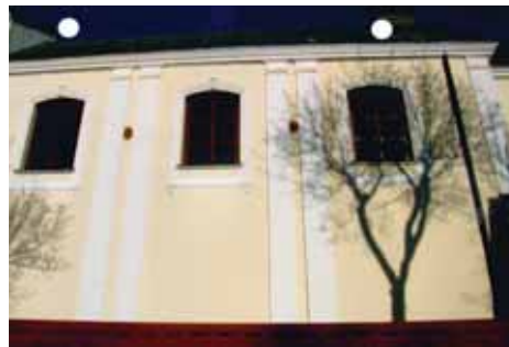
▲ Wymiana stolarki okiennej w kościele parafialnym w Wyszkwicie (2017 r.)
