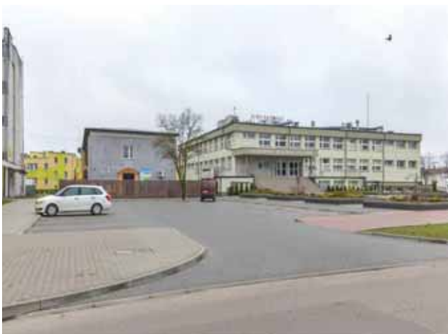
▶ Remont parkingu przy Węgrowskim Ośrodku Kultury w Węgrowie oraz przebudowa chodnika i zatoki postojowej w ciągu drogi powiatowej nr 4225W ul. Mickiewicza w Węgrowie - 161 934 ,23 zł
