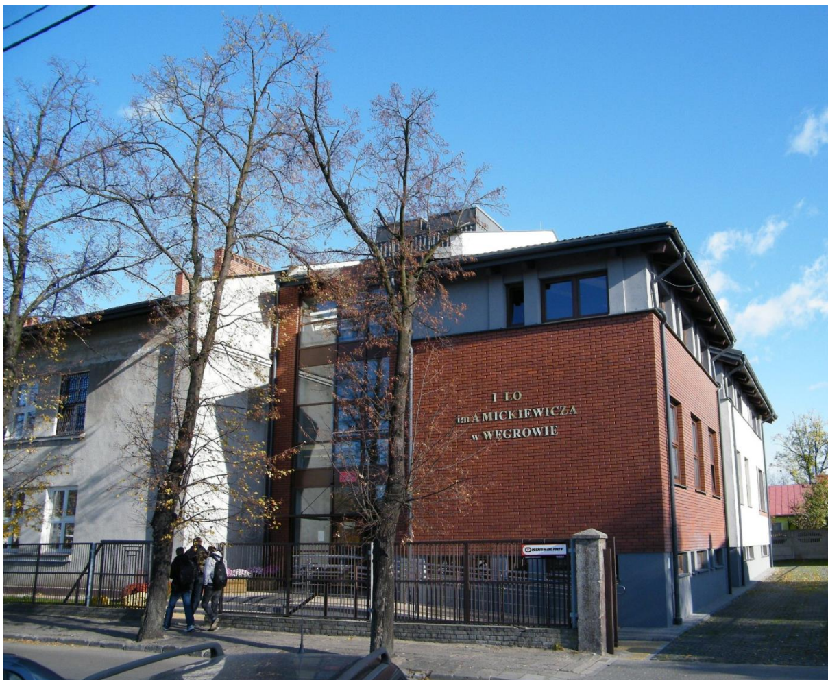
Zdjęcie 4 Nowo wybudowana część I Liceum Ogólnokształcącego im. Adama Mickiewicza w Węgrowie
