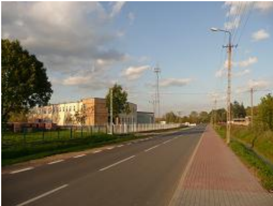
Zdjęcie 9 Nowa inwestycja Piekarnia Robson przy ul. Myśliwskiej
